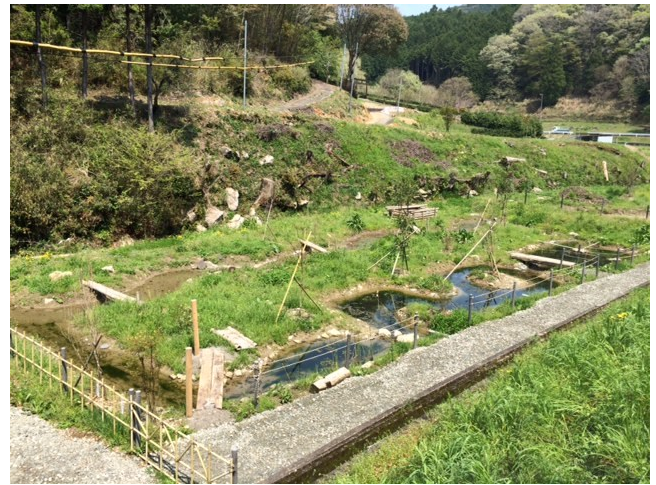
【川】 完成した別所ビオトープ（3/25）
